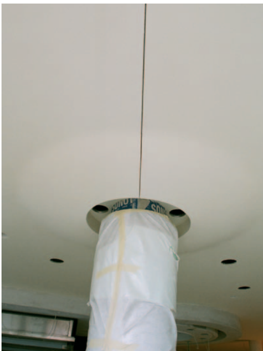
Die designorientierte Trockenbaulösung wurde mit einer Dehnfuge versehen.
