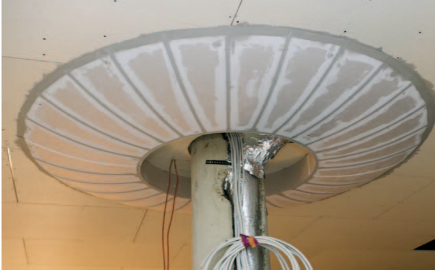
Konvexe, kuppelartig hergestellte Elemente dienen als optische Säulenumrandungen für vier dominante Säulen im Restaurantbereich.
